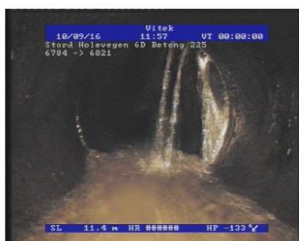
Figur 3: Rørinspeksjon som viser utette rør – grunnet utett rørskjøt, rotinntrenging og kollaps. (Foto: Stord kommune/Vitec)
