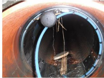
Figur 18: Driftsproblem – hastighetssensor tildekket av avløpssøppel (her: gipsplate. mer vanlig er filler og papir)
