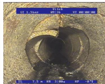
Figur 3: Rørinspeksjon som viser utette rør – grunnet utett rørskjøt, rotinntrenging og kollaps. (Foto: Stord kommune/Vitec)
