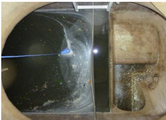
Figur 2: Eksempel, nivåvakt. Vippelogger, registrerer når vannnivå når et visst nivå. (Foto: Norconsult)
