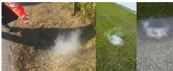
Figur 4: Røyk som siver opp fra bakken og sluk grunnet lekkasje i rør og feilkoblinger. (Foto: Porsgrunn kommune)
