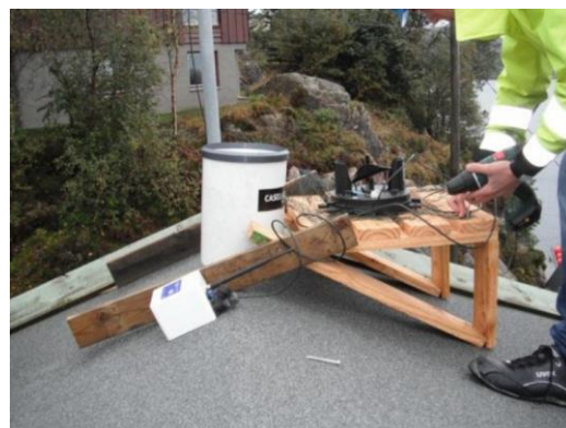
Figur 12: Montering av midlertidig nedbørmåler på tak. Foto: Norconsult
