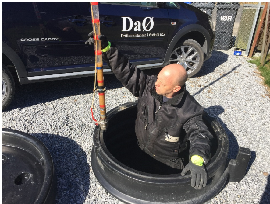
Figur 4. Slamprøverør for måling av slamdybde i et minirenseanlegg.
