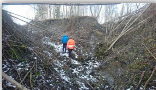
Utfordring med erosjon i bekkedal i Enebakk grunnet manglende kontroll med overvann på ovenforliggende jordbruksareal.. Foto: Terje Fossen-Hellesjø
